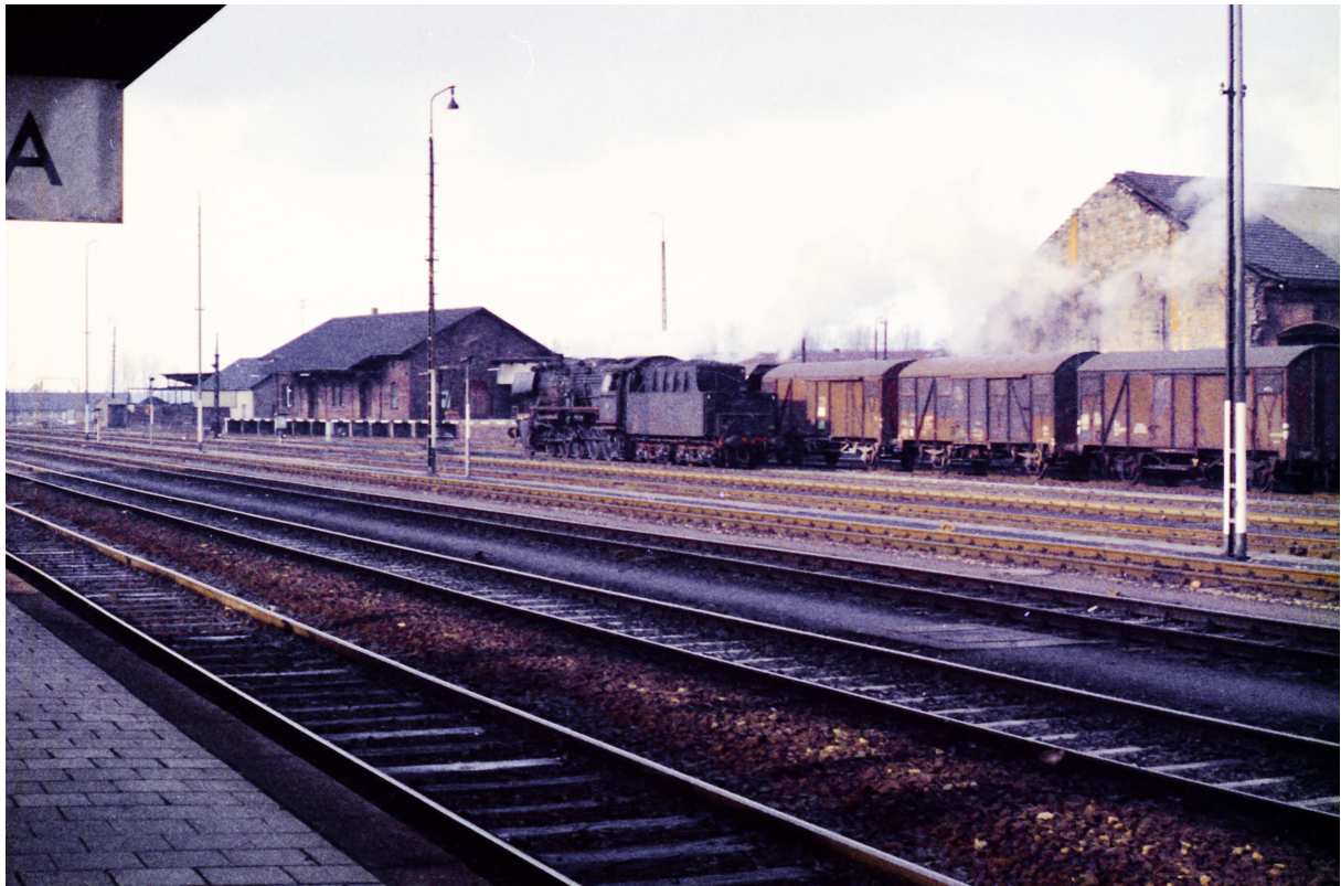
(Ganze Bahnhofszeilen wurden abgerissen Foto Archiv Herrenknecht)
